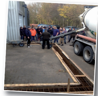
Herstellung der Streifenfundamente / Bauh-16a
